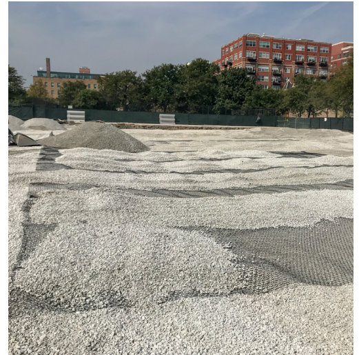
(Arriba) Lluvias excesivas afectaron el progreso de esta obra. (Abajo) La geomalla Triax de Tensar permitió un ahorro de aproximadamente $500,000 dólares y la terminación del proyecto un mes antes de la fecha programada.
