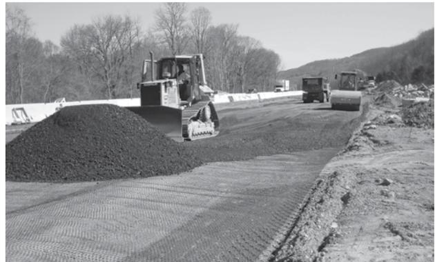
**IMAGEN 9B:** Distribución del relleno de agregado sobre la geomalla Tensor.
