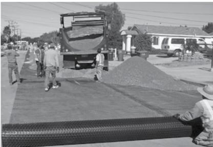
**IMAGEN 4:** La geomalla debe traslaparse en dirección al avance del relleno.
