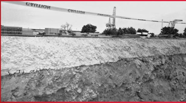
**IMAGEN 13:** Una excavación con retroexcavadora a través de geomalla Tensar.
