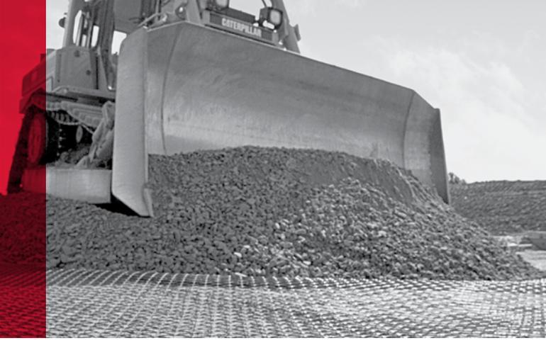
**IMAGEN 8:** Descarga de relleno de agregado sobre la geomalla Tensor® encima de la subrasante competente.
