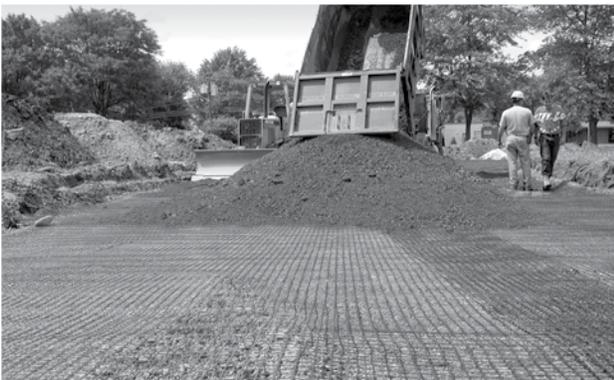
**IMAGEN 9A:** Descarga de relleno de agregado sobre la geomalla Tensor encima de una subrasante blanda.
