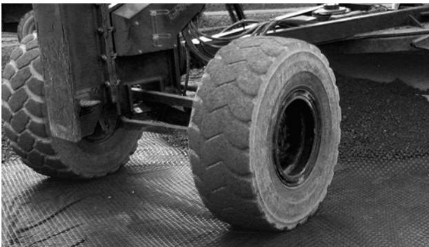
**IMAGEN 12:** Las geomallas pueden ser colocadas directamente por equipos de neumáticos.
