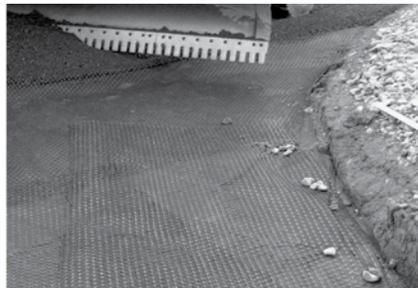
**IMAGEN 5:** Colocación de la geomalla para adaptarla a las curvas.
