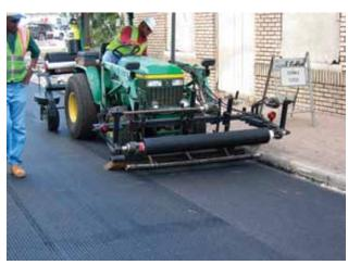
Una instalación de ancho completo con GlasGrid usando un dispositivo de instalación de alta velocidad de 1.5 m (5 pies) de ancho.
