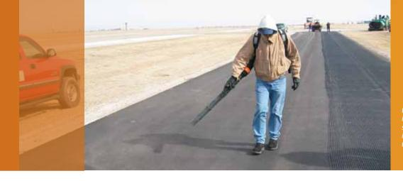
La preparación de la superficie incluye la limpieza mediante soplado del polvo antes de instalar el sistema autoadhesivo GlasGrid
