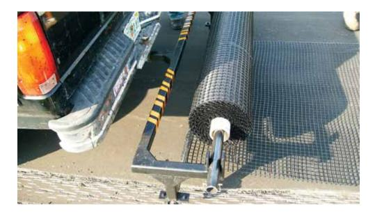
IMAGEN J: En áreas de pavimento más pequeñas se pueden instalar los rollos manualmente.
