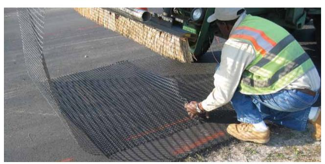
La colocación del producto GlasGrid en la transición a un nuevo rollo requiere algo de experiencia y capacitación, sin embargo, los instaladores experimentados lo realizan con facilidad.
