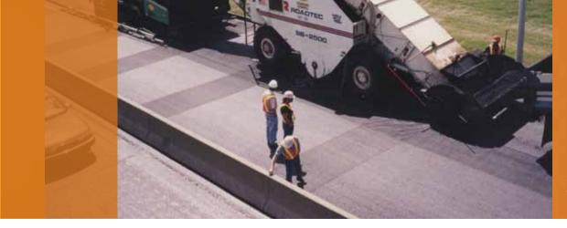
reparaciones de detalles GlasGrid, donde se usa un dispositivo de transferencia de asfalto como parte del tren de
