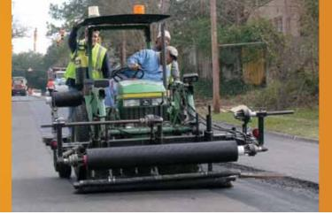
Los rollos GlasGrid de 1.5 m (5 pies, permiten una rápida instalación debido a su fácil manejo y menos mano de obra.
