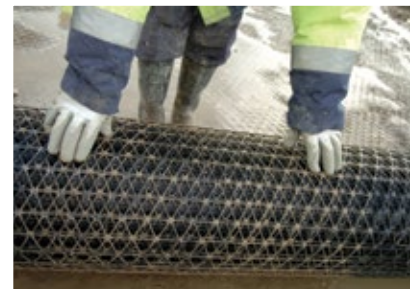
Los tamanos estándar de los rollos hacen que la manipulación de la geomalla TriAx sea sencilla y se genere una cantidad mínima de desperdicios.
