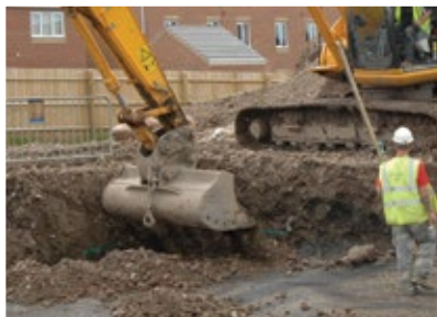
La Geomalla TriAx hace frente a los suelos blandos con facilidad y proporciona una sólida plataforma de construcción.
