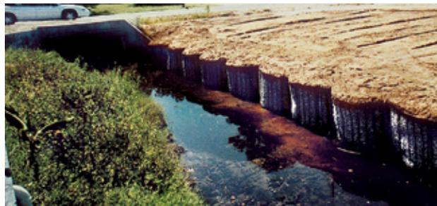
Las geoceldas circulares Triton ancladas por las geomallas Tensor ofrecen soluciones económicas y fáciles de instalar para aplicaciones como este muro en el canal en una comunidad residencial.
