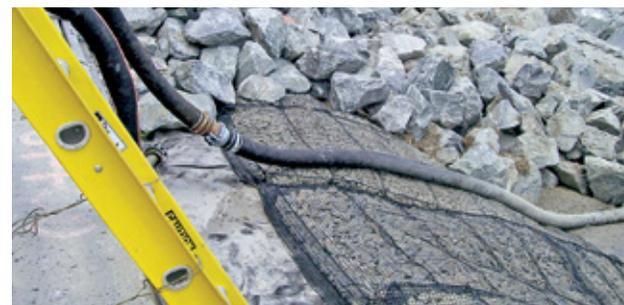
*Como fundación de revestimiento, el geocolchón ofrece estratificación y filtración, contribuyendo a evitar el asentamiento diferencial. El geocolchón también protege contra la socavación al pie del revestimiento.*
