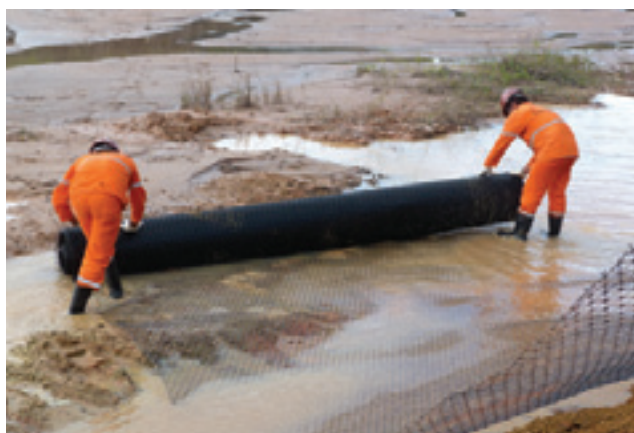
El uso de las geomallas TriAx de Tensar reduce los costos iniciales y el mantenimiento futuro.
