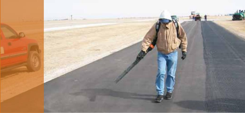
La preparación de la superficie incluye la limpieza mediante soplado del polvo antes de instalar el sistema autoadhesivo GlasGrid.
