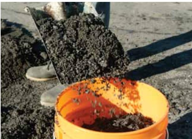
**IMAGEN A:** El asfalto fresado que contiene el producto GlasGrid se puede reciclar fácilmente para usarlo en otros proyectos.
