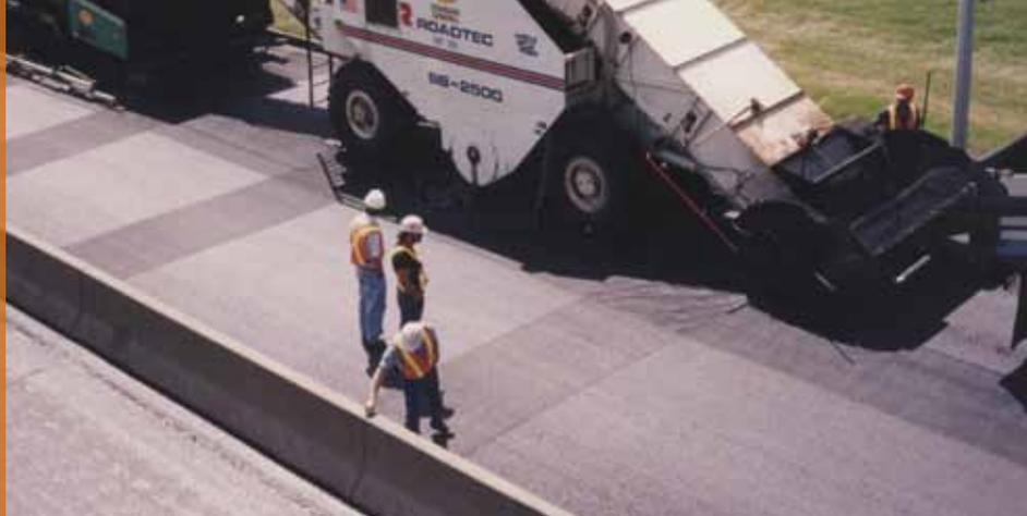
*Instalación para reparaciones de detalles GlasGrid, donde se usa un dispositivo de transferencia de asfalto como parte del tren de pavimentación.*
