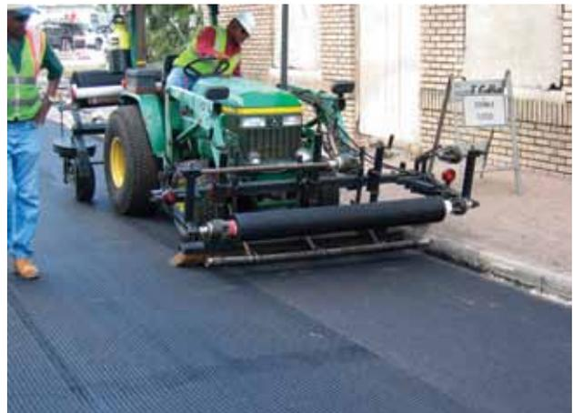
Una instalación de ancho completo con GlasGrid usando un dispositivo de instalación de alta velocidad de 1.5 m (5 pies) de ancho.
