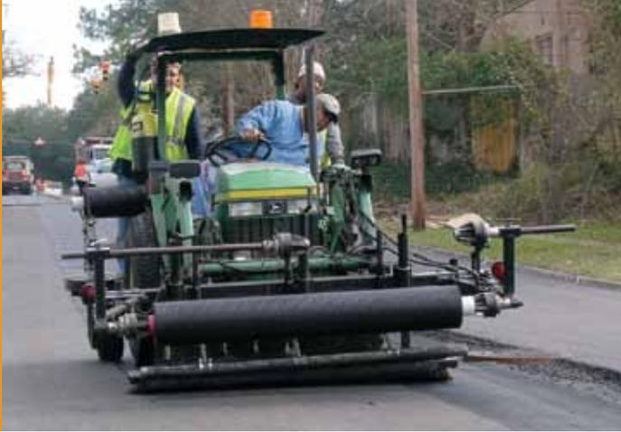
Los rollos GlasGrid de 1.5 m (5 pies) permiten una rápida instalación debido a su fácil manejo y menos mano de obra.
