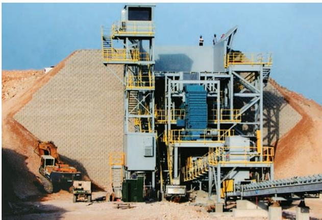
As Soluções de Separação de Leito/Greide Tensar podem ser construídas com uma variedade ampla de materiais de preenchimento e diversos tipos de revestimentos de face.
