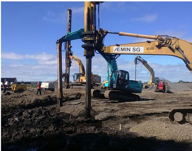
Instalación de elementos para pilas de agregado apisonado Geopier.
