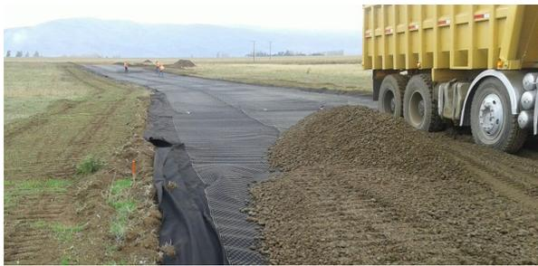
La instalación de Tensar TriAx160 reduce los requisitos en agregados de las vías de acceso.
