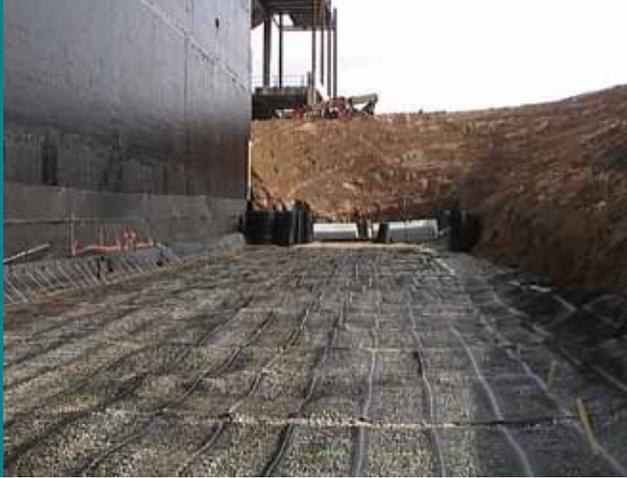
*The John Paul Jones Arena en la Universidad de Virginia combinó el sistema Geopier, en lugar de los pilotes perforados, con un muro de alivio de presión SierraScape® para eliminar los costosos muros de contención de concreto.*
