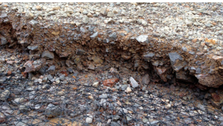
A estrutura exclusiva da Geogrelha Tensar TriAx proporciona alto grau de rigidez em solo plano, com melhoria do desempenho.
