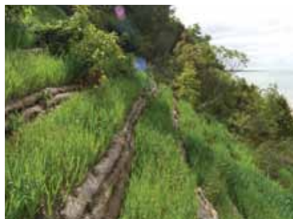
Restauração da escarpa do lago Michigan – South Haven, Michigan
