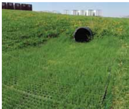
Descarga de bueiro – Poseyville, Indiana
