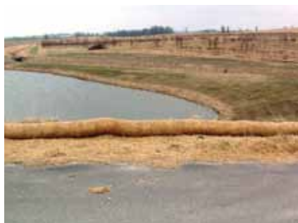
Instalação de BioWattle – Poseyville, Indiana
