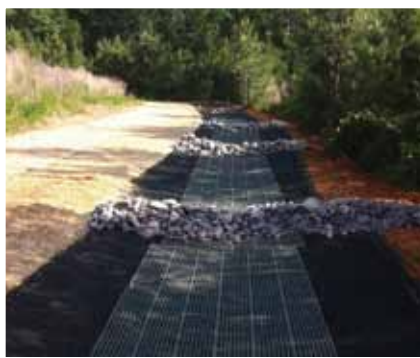
Local da fonte de energia do ponto central – Shreveport, Louisiana
