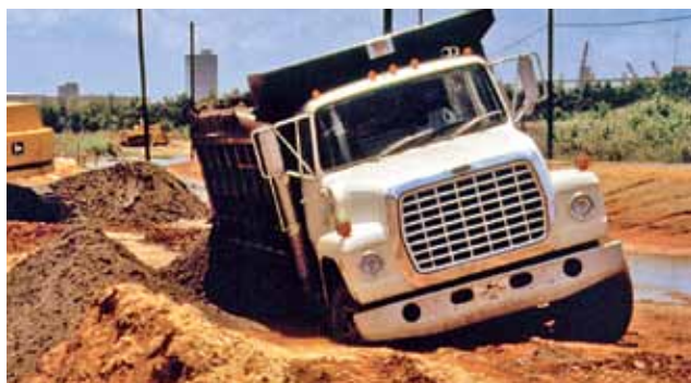
Rodovia de acesso – Mobile, Alabama
