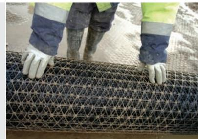
Les rouleaux de géogrille TriAx de dimension standard se manipulent facilement et produisent un minimum de déchets.
