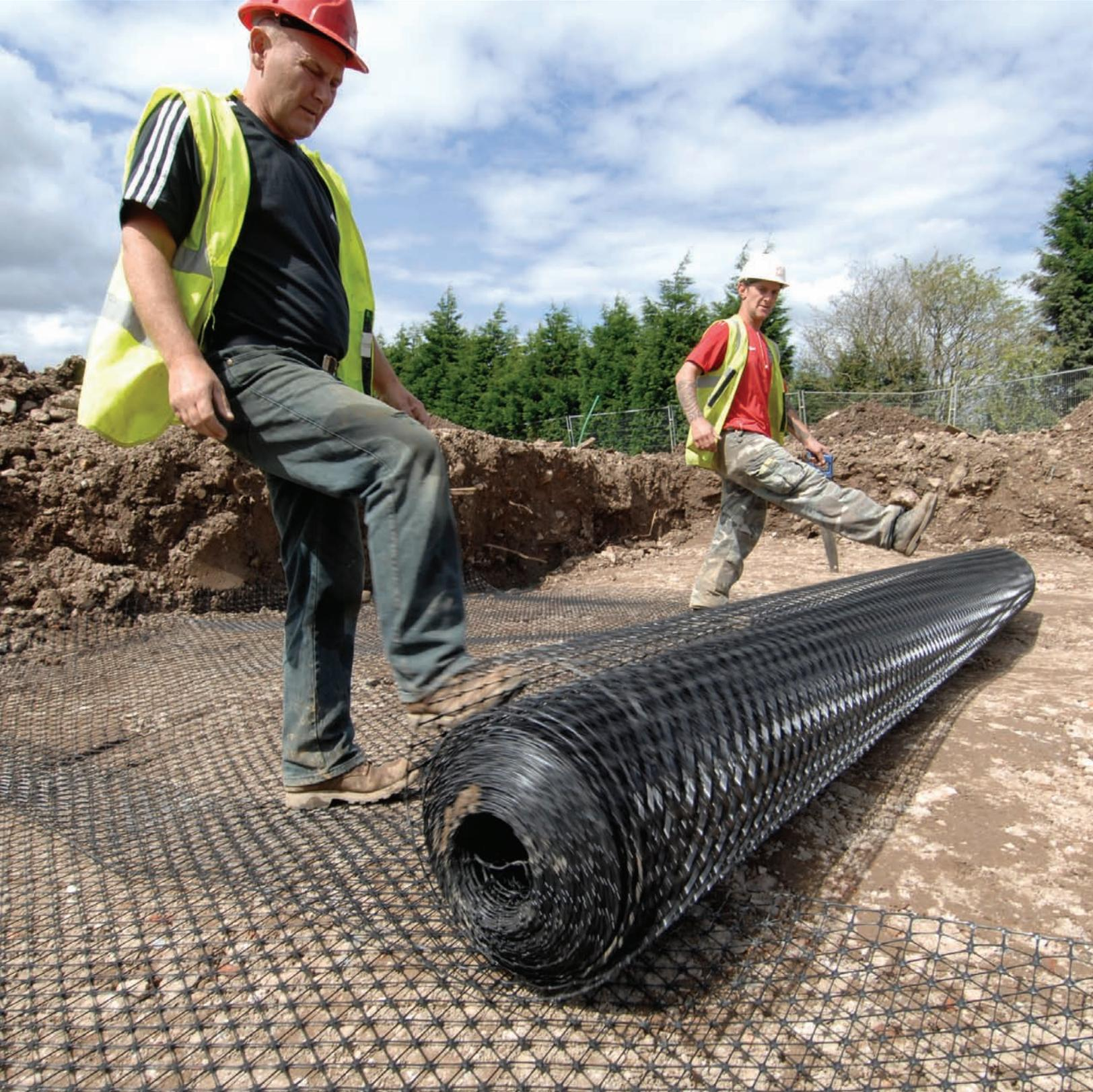
Les géogrilles Tensar<sup>MD</sup> TriAx<sup>MC</sup> représentent une amélioration technologique significative dans le renforcement des sols à faible capacité portante car elles contribuent à allier économie de construction et durabilité des infrastructures.
