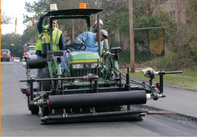
Les rouleaux de GlasGrid de 1,5 m (5 pi) de large permettent une pose rapide en raison de la manipulation facile et d'une main-d'œuvre réduite.
