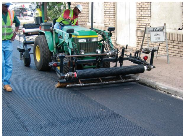
Pose de GlasGrid sur toute la largeur au moyen d'un dispositif de pose à grande vitesse d'une largeur de 1,5 m (5 pi).
