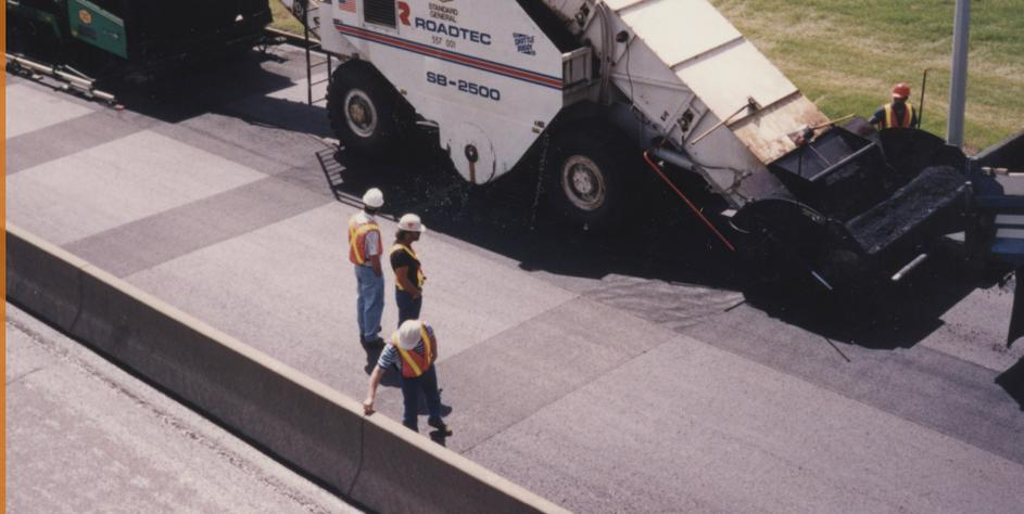
*Pose pour réparation de GlasGrid dans laquelle un dispositif de transfert d'asphalte est utilisé comme élément d'un train de finisseuses.*
