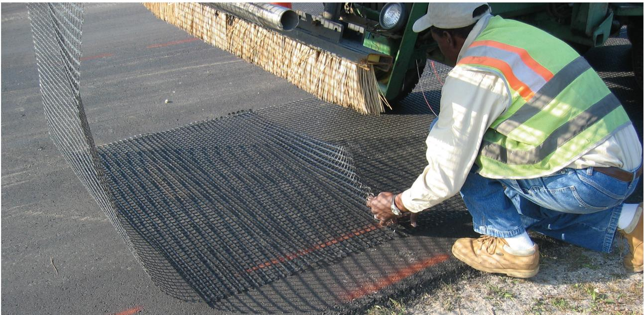
*Le positionnement du produit GlasGrid lors de la transition vers un nouveau rouleau nécessite expérience et formation. Cependant, il est facile à manipuler par des installateurs expérimentés.*
