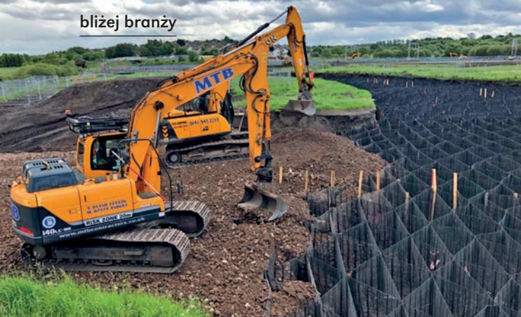
System TensarTech® Stratum® – posadowienie na materacu geokórkowym
