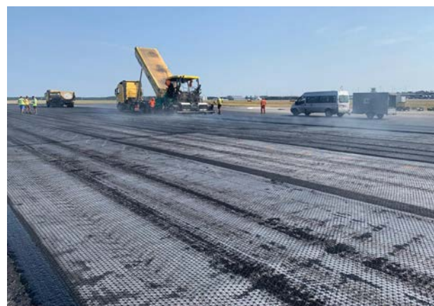
Zbrojenie warstw asfaltowych
