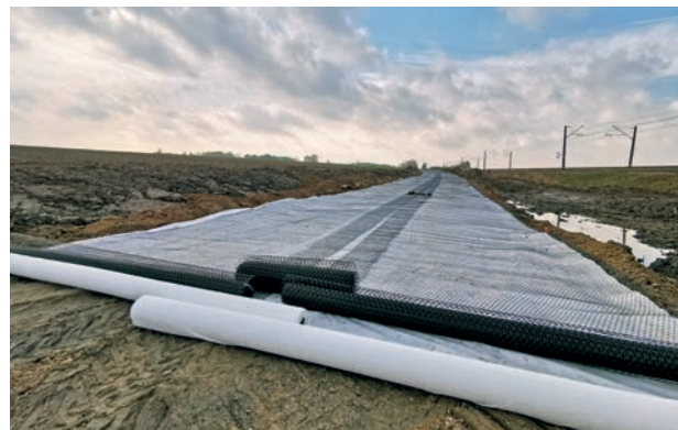
Zastosowanie georusztu Tensar® TriAx®
