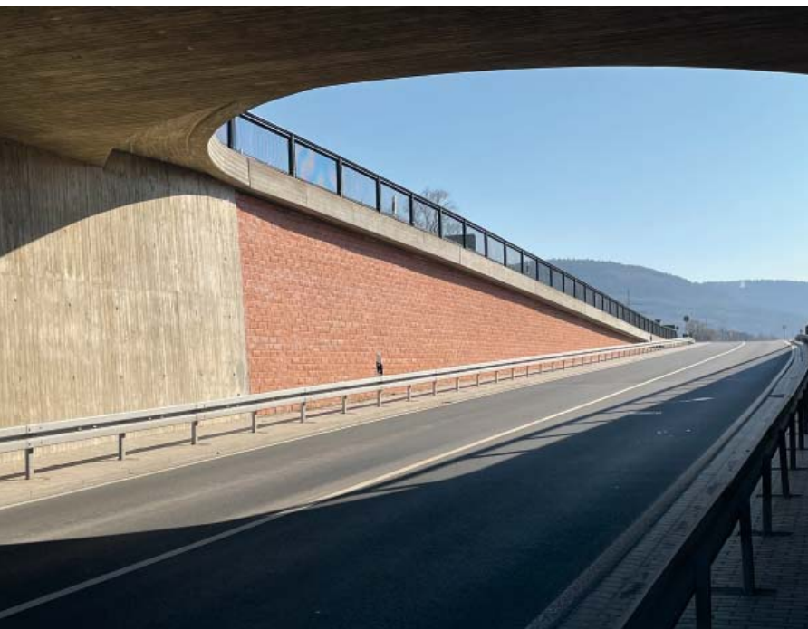
Bild 1: Kreisverkehrsplatz im Landkreis Miltenberg – geogitterbewehrte modulare Betonwand an einer Auffahrt
