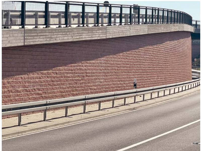
Bild 2: Kreisverkehrsplatz im Landkreis Miltenberg – geogitterbewehrte modulare Betonwand an einer Abfahrt
